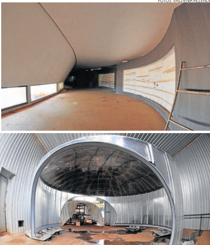
FORMA. Corredores já tiveram peças de acrílico instaladas (no alto), e peça principal, e maior delas (acima) será encaixada na terça-feira
