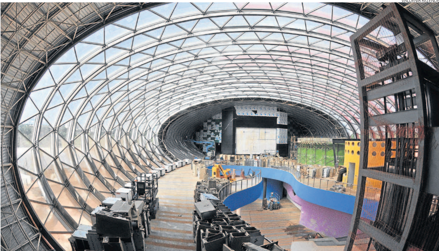
AVANÇO. A entrada do Aquário do Pantanal está praticamente pronta, com a maioria dos equipamentos aguardando instalação
