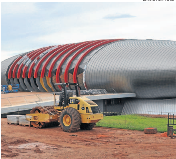
PARADA. Construção do Aquário não tem data para ser concluída
