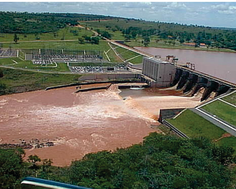
Usina Hidrelétrica Assis Chateaubriand - Ribas do Rio Pardo/MS.
