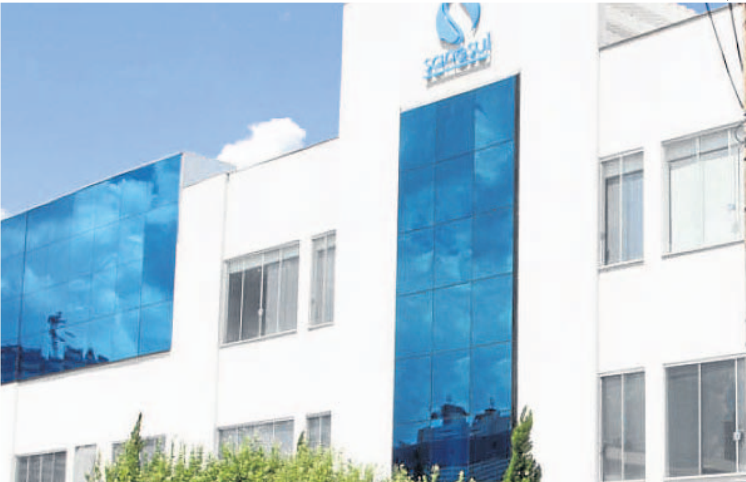
SANESUL. Parceria é justificada pela dificuldade de investimento na universalização do saneamento em municípios atendidos pela empresa
