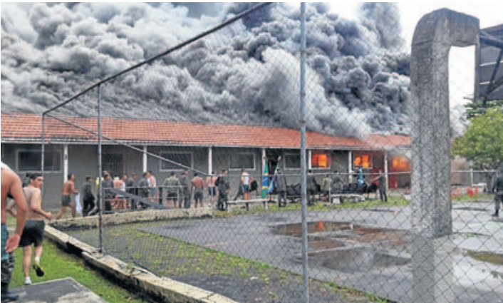
DESTRUIÇÃO. Fogo atingiu área extensa de pavilhão do quartel
