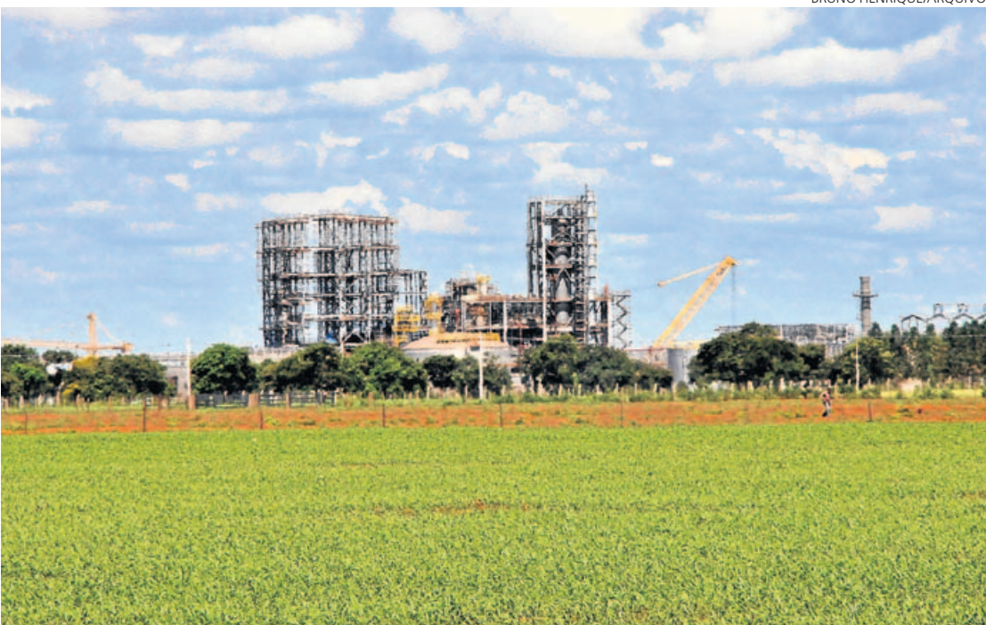
UFN3. Com mais de 80% da obra concluída, MPF entende que Petrobras deveria finalizar fábrica em MS
