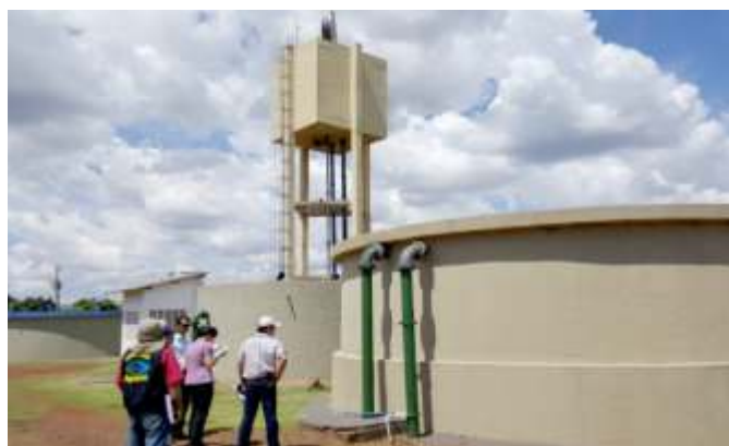
23/03 - Reservatório de Água no município de Sidrolândia - MS.
