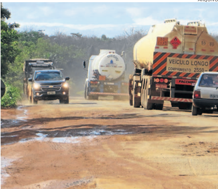
INTERIOR. Estrada teve graves problemas de conservação em 2016
