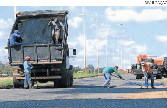
ASFALTO. Rodovia, atualmente, é mantida pelo governo do Estado
