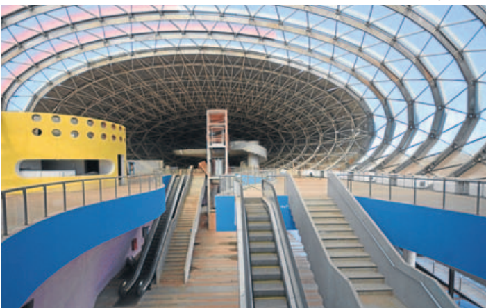
CANTEIRO. Obra foi paralisaada em 2015 e não há data para conclusão
