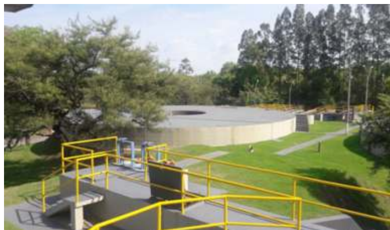
Estação de Tratamento de Esgoto de Bonito
