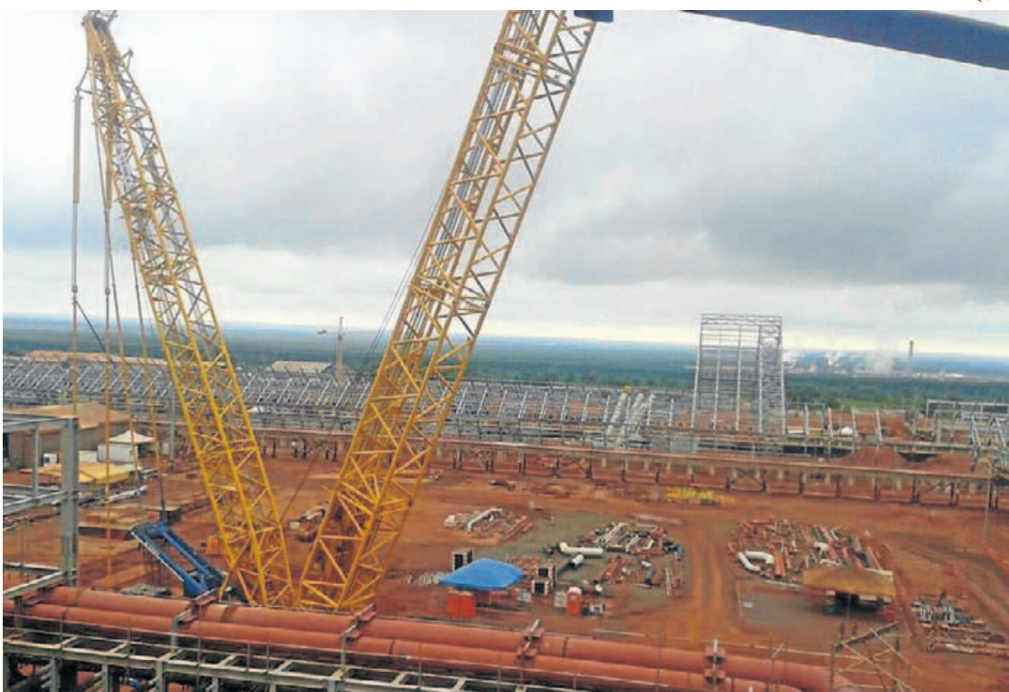
UFN3. Retomada da obra da unidade paralisada em 2014 pela Petrobras deve custar R$ 2 bilhões
