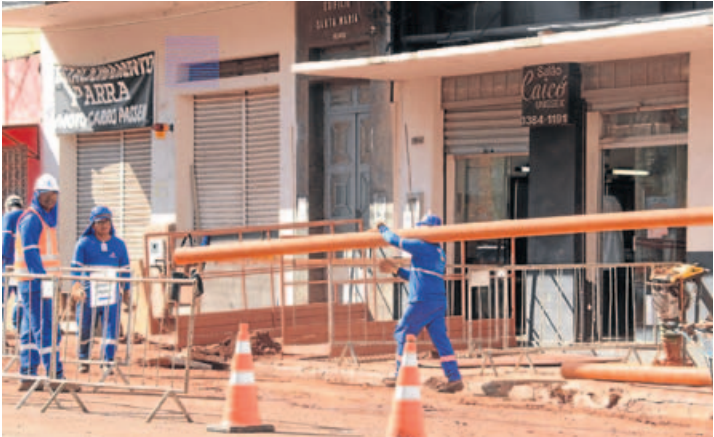
DUTOS. Instalação dos tubos teve início na semana passada
