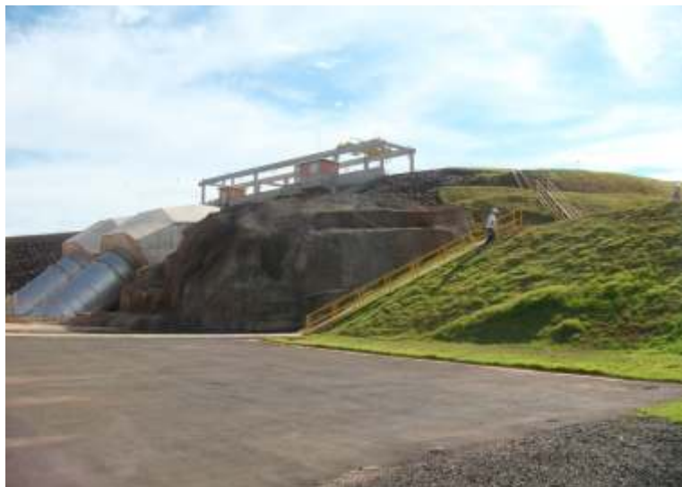
PCH Alto Sucuriu - Jusante da Barragem
