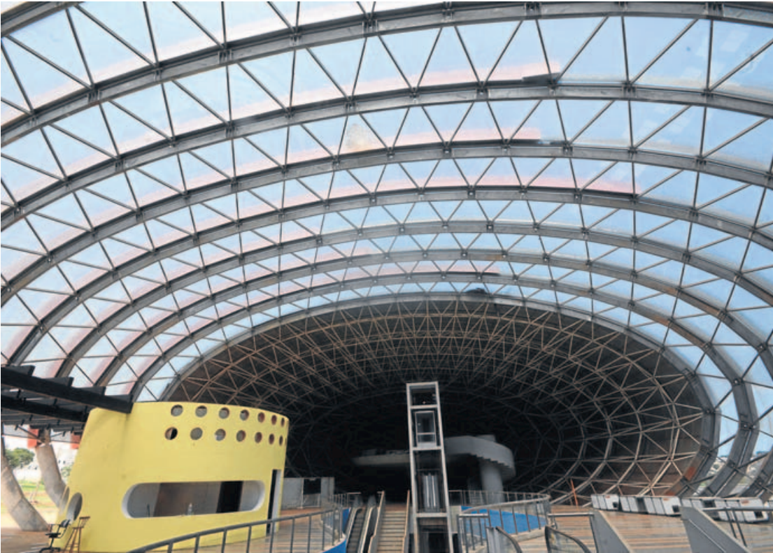
AGORA VAI. Placas que precisam ser trocadas já foram medidas e trabalho deve começar
