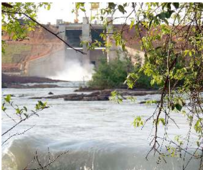
Usina Hidrelétrica São Domingos, localizada no Rio Verde, entre os municípios de Água Clara e Ribas do Rio Pardo.
